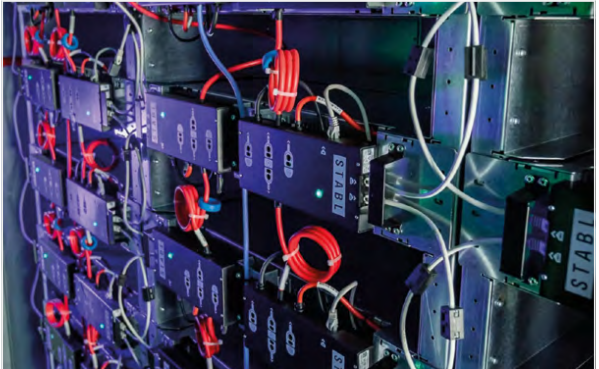
Modulares Batteriespeichersystem „Battery Racks“ auf Basis von Second-Life-Fahrzeugbatterien – STABL Energy; stabl.com
